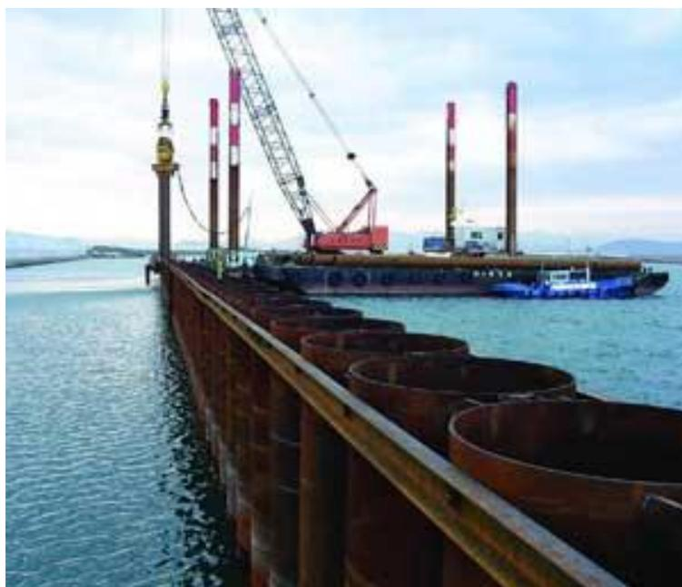
図 2-5 鋼製遮水工
